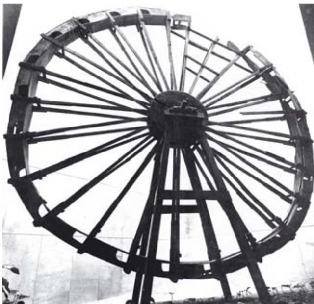
Fig. 2.25 Noria localizada en el interior de las minas de Riotinto (Huelva) (según Antona y Gómez, 1987, 58)
