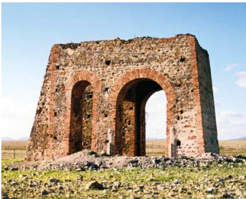
Fig. 6.3 Castillete de mampostería de la Mina Los Dolores (Almodóvar del Campo) (Foto A. Manzanares-P. Hevia)
