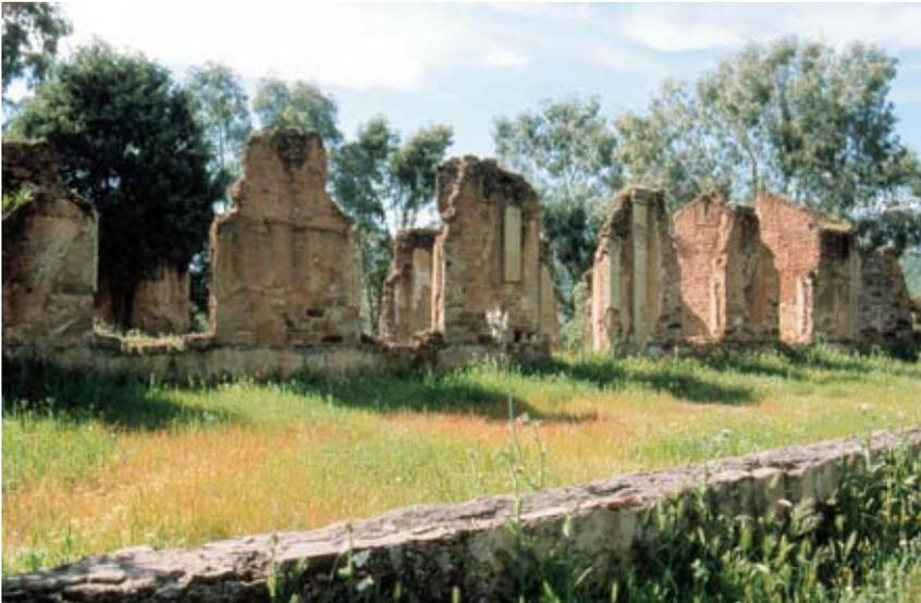
Fig. 6.13 Restos de construcciones de tapial del pueblo minero de Nava de Riofrío (Foto A. Manzanares-P. Hevia)
