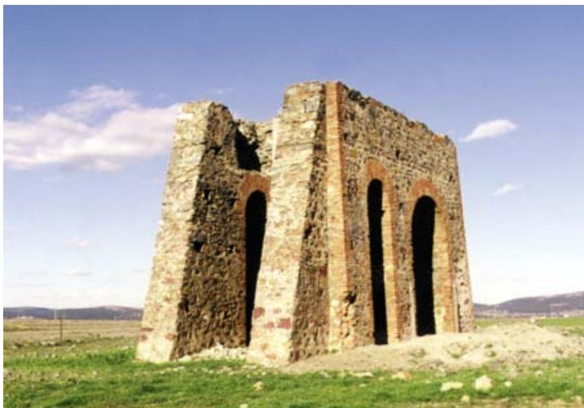
Fig. 6.7 Castillete de mampostería y ladrillo de la Mina Los Dolores (Foto A. Manzanares-P. Hevia)
